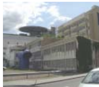
Hubschrauberlandeplattform auf dem Gelände des Westpfalz-Klinikums
