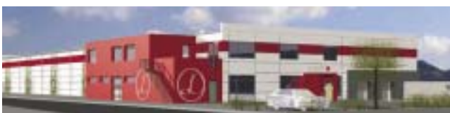
Das zukünftige Logistikzentrum der Firma Lutz im IG Nord
