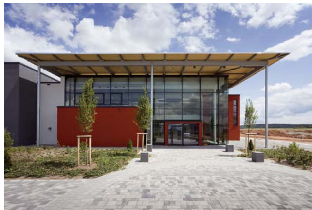
Eingangsbereichs des neuen Werks von Fuchs Lubritech
