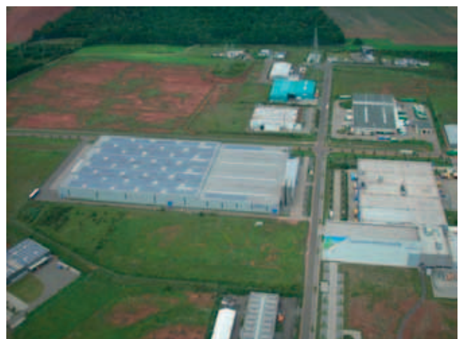
Solaranlage auf dem Dach der Dienes Packaging GmbH
