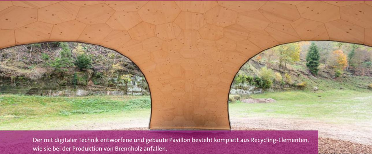
Der mit digitaler Technik entworfene und gebaute Pavillon besteht komplett aus Recycling-Elementen, wie sie bei der Produktion von Brennholz anfallen.
