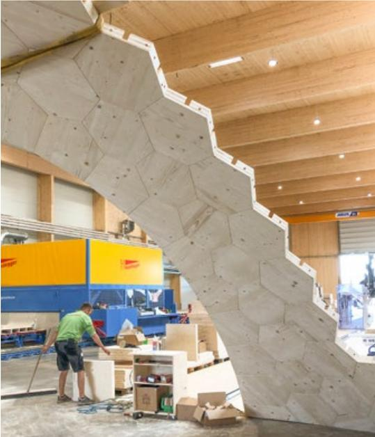
Dank eines innovativen Schnellmontagekonzepts mit Hartholzverbindern anstelle von Metall lässt sich die Dachkonstruktion schnell und präzise montieren.
