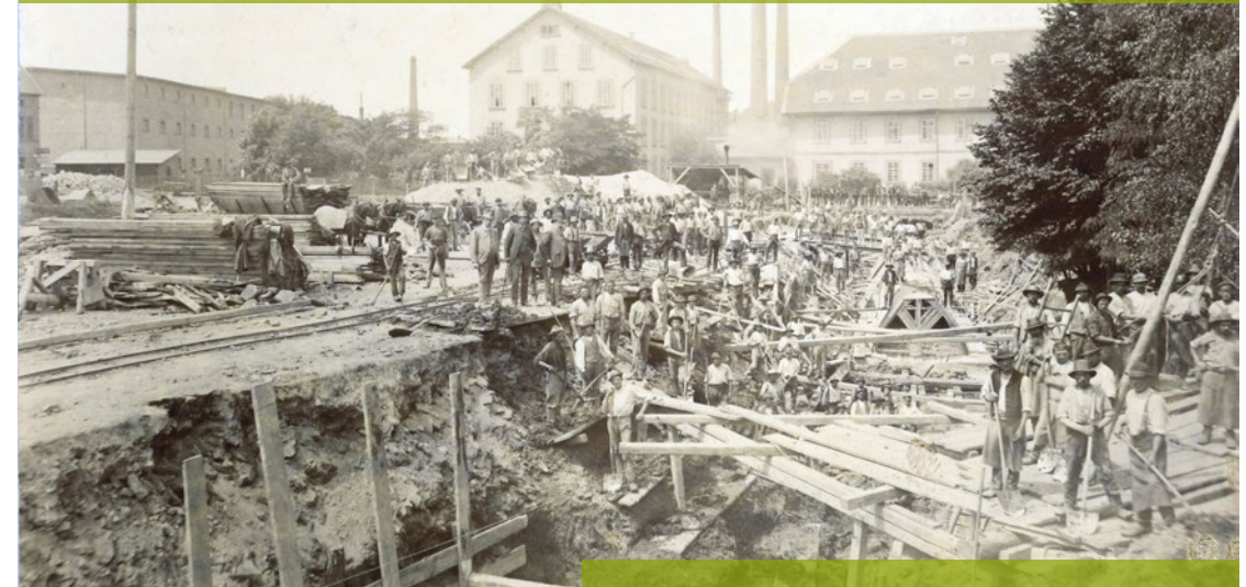
Baustelle Lauterkanal im Bereich Kammgarnspinnerei, 1893.
